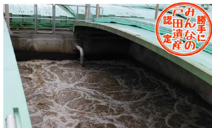
▲反応タンク。水に送り込んだ空気で泡立っている。
